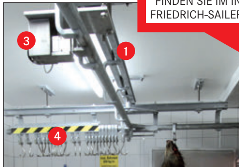
3 Rohrbahnwaage 4 Eurohaken mit Nebenhaken
